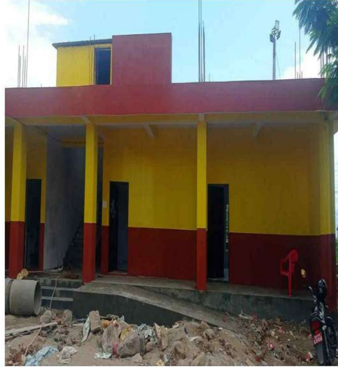
श्री बालविकास आ.वि.भवन निर्माण, वडा न. १७
