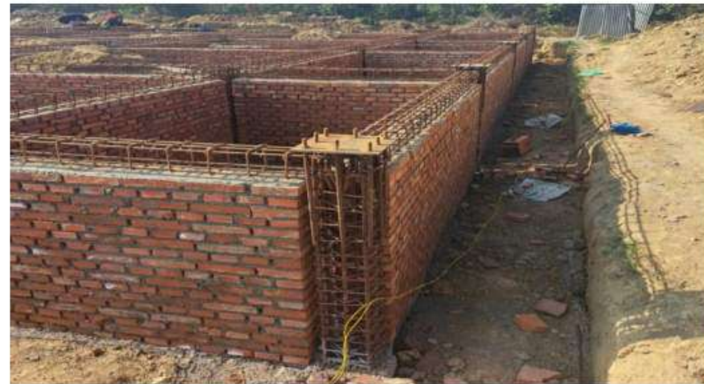
तिलोत्तमा नगरपालिकाको सभा हाल निर्माण
