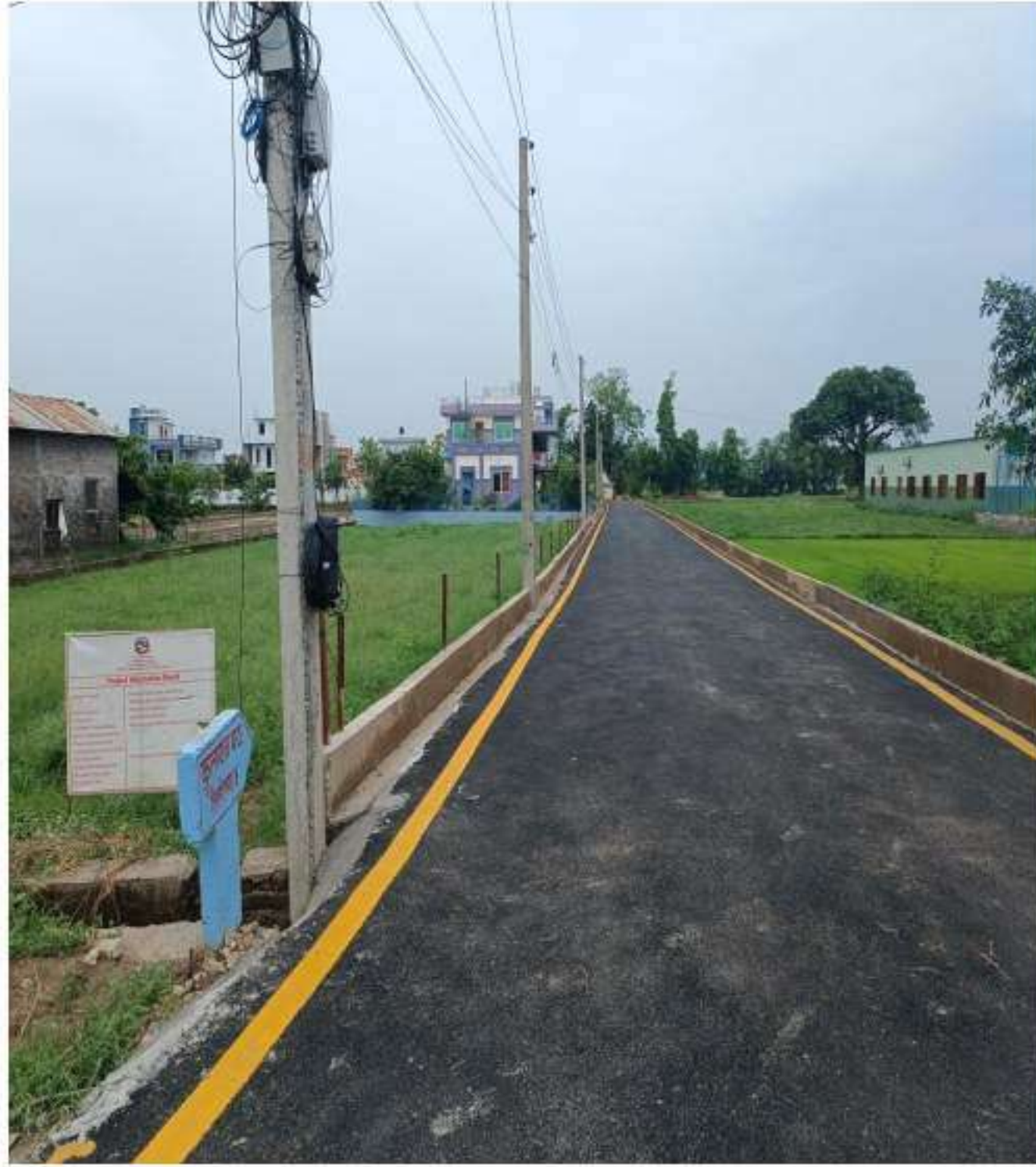
कुलायन पथ सडक निर्माण , वडा न. ०५
